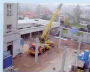
▲ stavba výrobní haly
